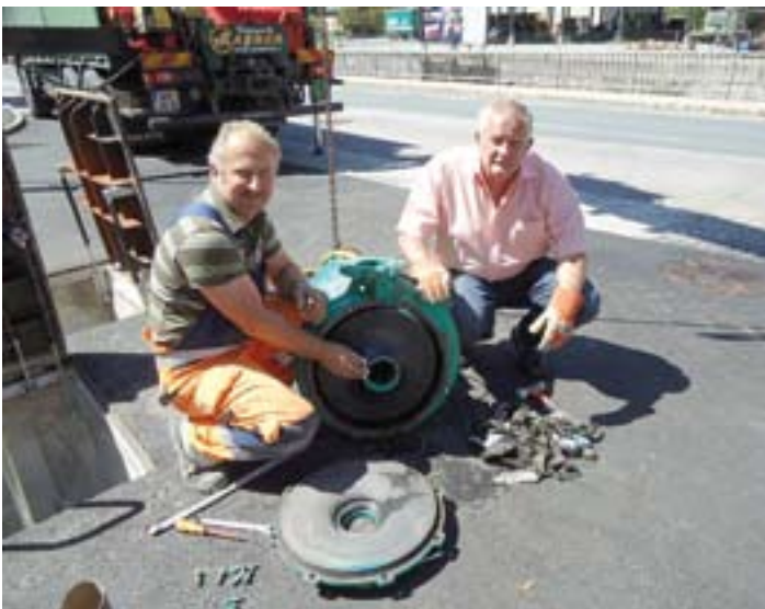
Josef Joham und Bürgermeister Franz Kogler beim Beheben des Schadens.
